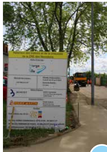
Réfection de la ZAE des Nouratons à Ruffey-lès-Échirey
